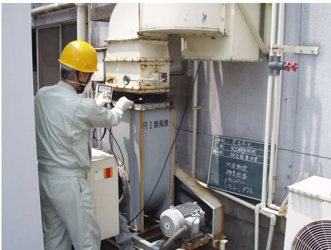
◇ R I 施設の解体・撤去作業
