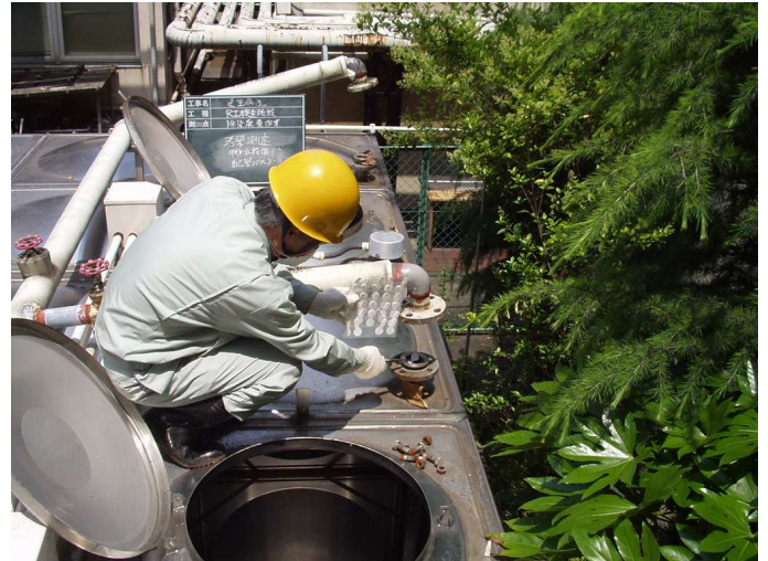
◇ R I 排水槽の除染作業
