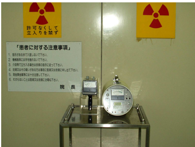
◇ 放射線治療室漏洩線量測定
